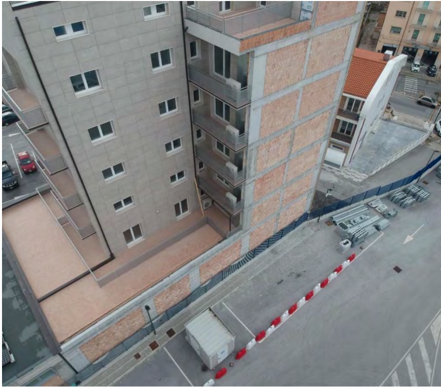
LATRICO CON AFFACCIO SU LOTTO ANAS
